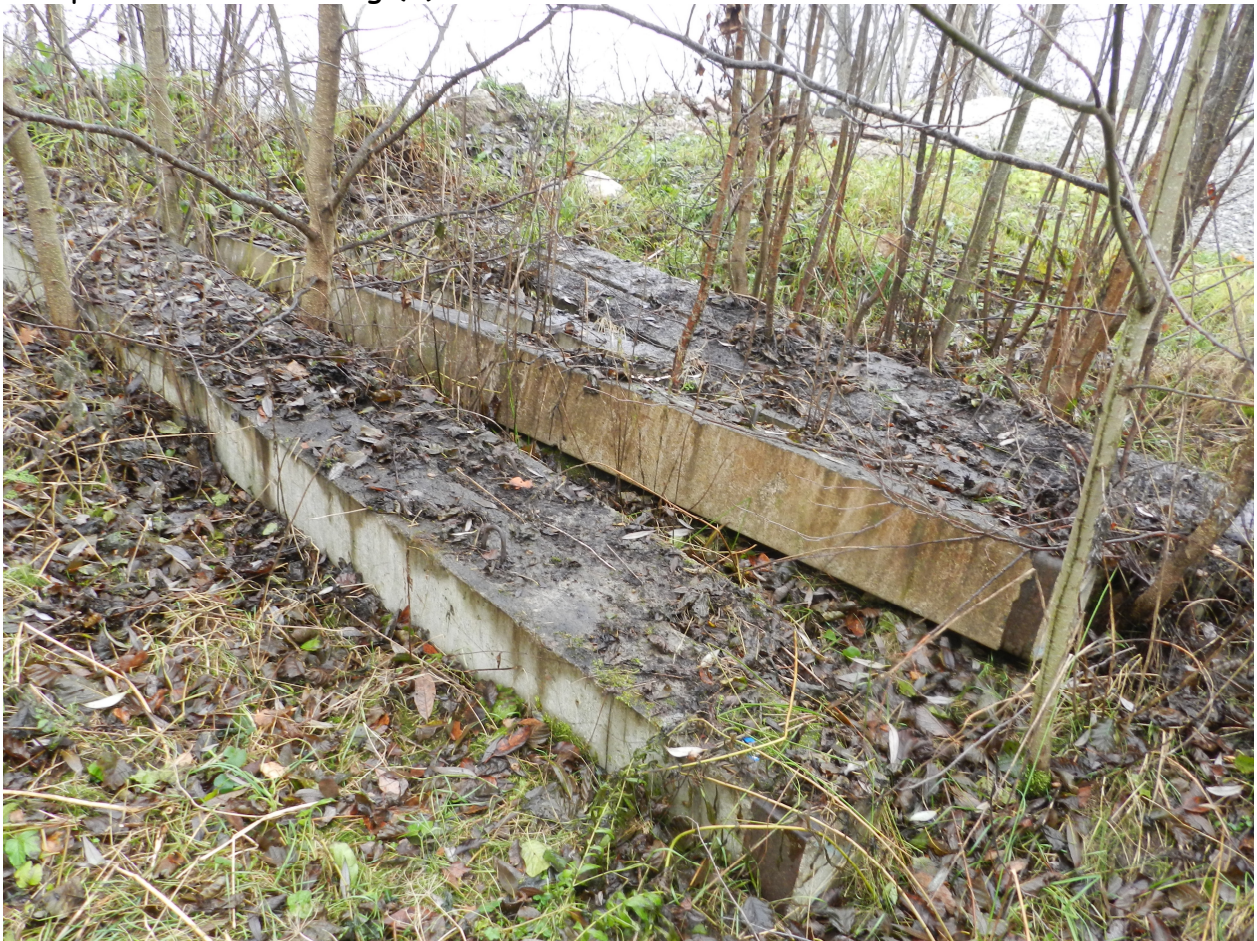
Bild på bärlinor av betong (2)
